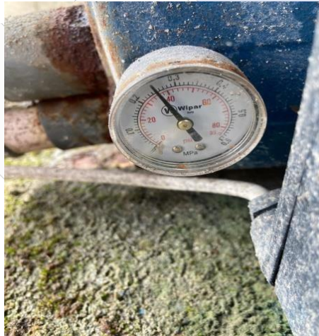
Gambar 4.7 Proses Pemeriksaan Tekanan Mesin Pompa
