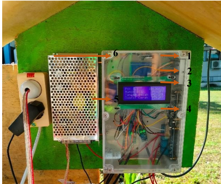
Gambar 4. 2 Panel Sistem Kontrol dan Monitoring
