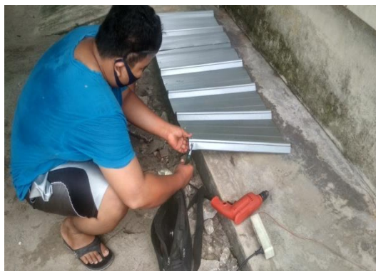
Gambar 4.6 proses pembuatan atap
