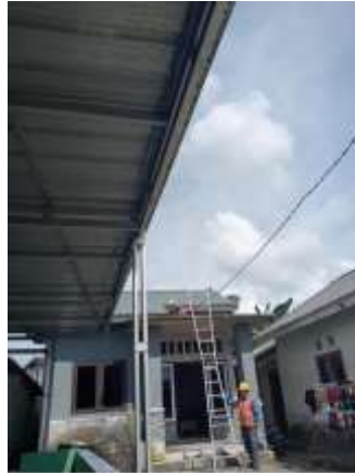
Gambar 2.9 Pengencangan Kabel Pelanggan
