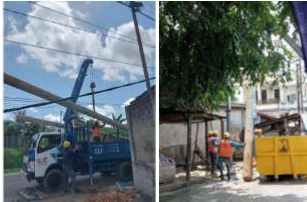
Gambar 2.8 Pemasangan Tiang Baru
