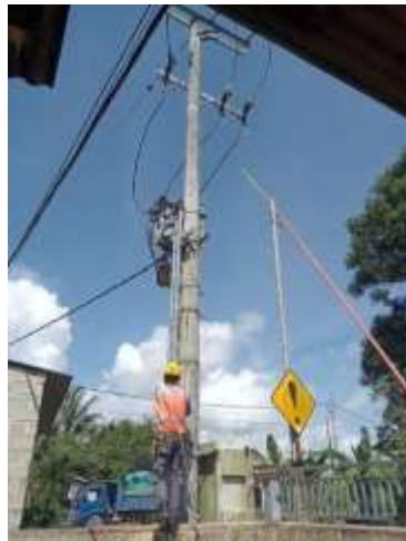
Gambar 2.11 Pemasangan Cover FCO
