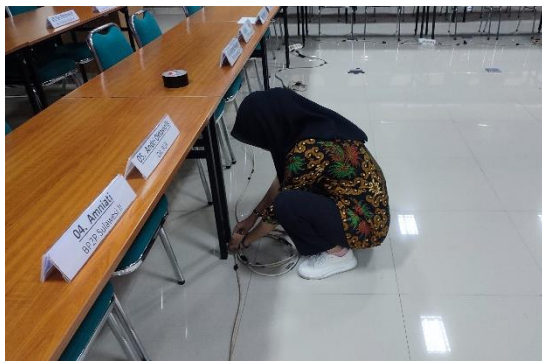
Gambar 1.33 Pemasangan Stop Kontak Ruang Kelas Pelatihan
