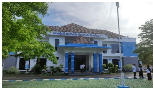
Gambar 1.2 Kantor Pelabuhan Perikanan Nusantara Sungailiat
