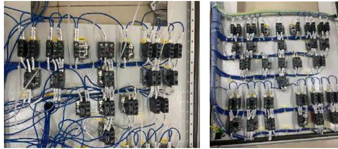
Gambar 2. 13 Wiring I/O Panel dan Perapihan
